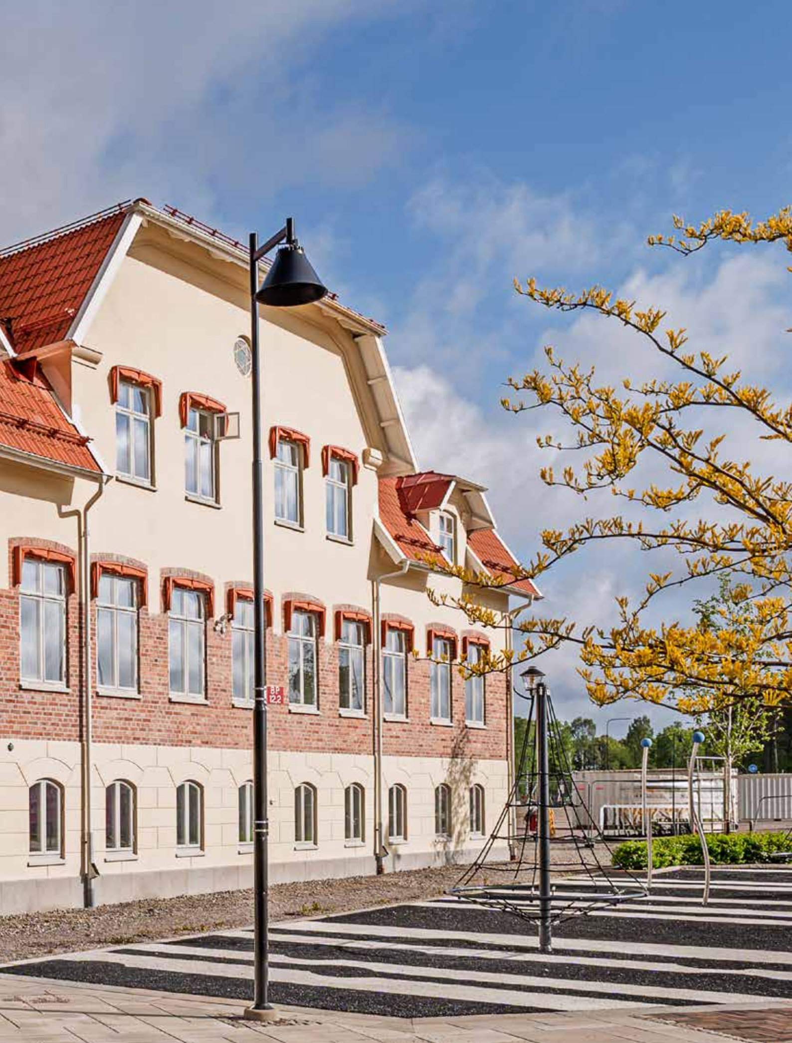
KONTORET 1, VÄRVIK, TROLLHÄTTAN. Renovering och ombyggnation av äldre fastighet till kontor. / BESTÄLLARE: Kraftstaden.
