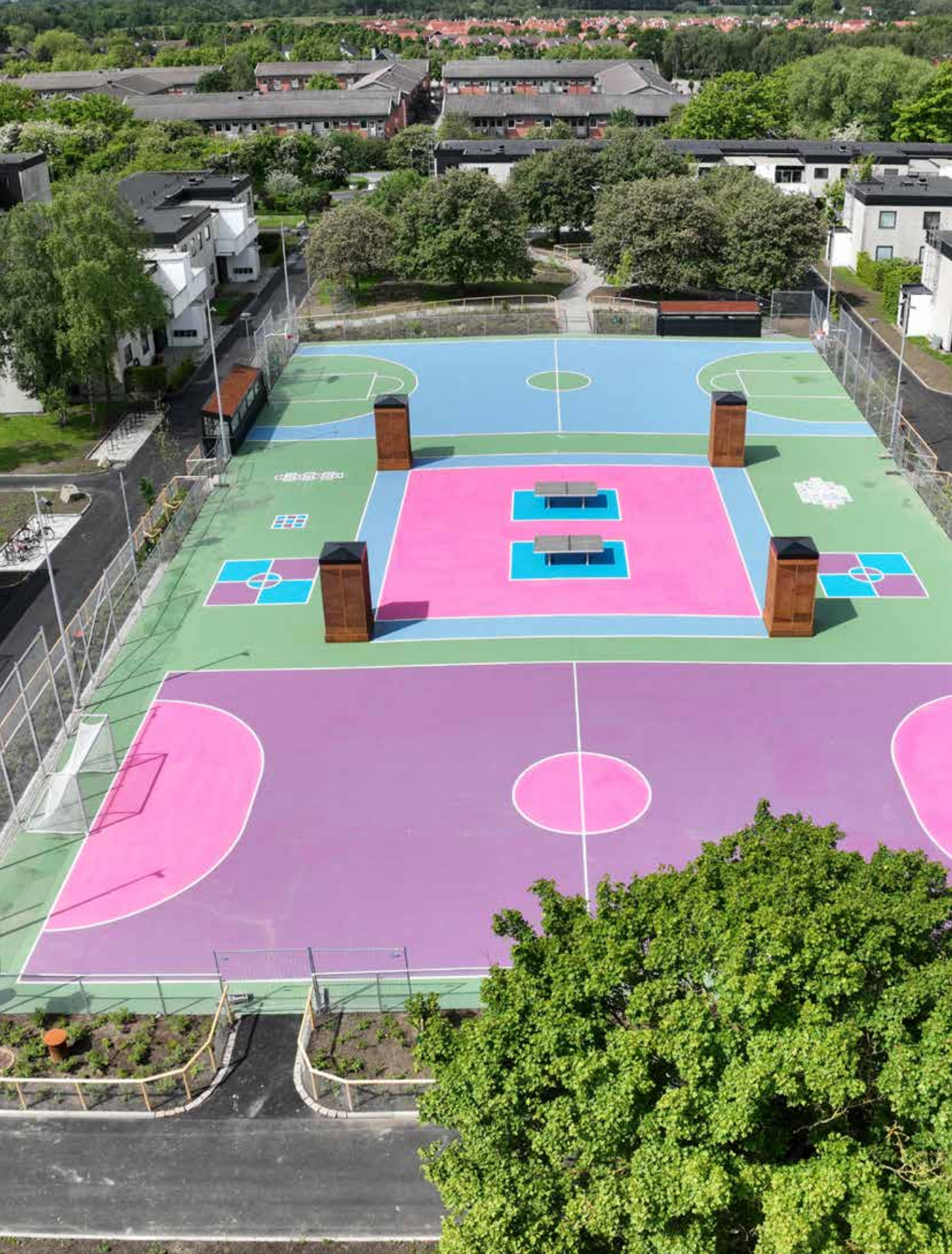
OFFERKÄLLAN, LUND. Anläggning av utemiljö i bostadsområde. / BESTÄLLARE: Lunds Kommuns Fastighets AB.
